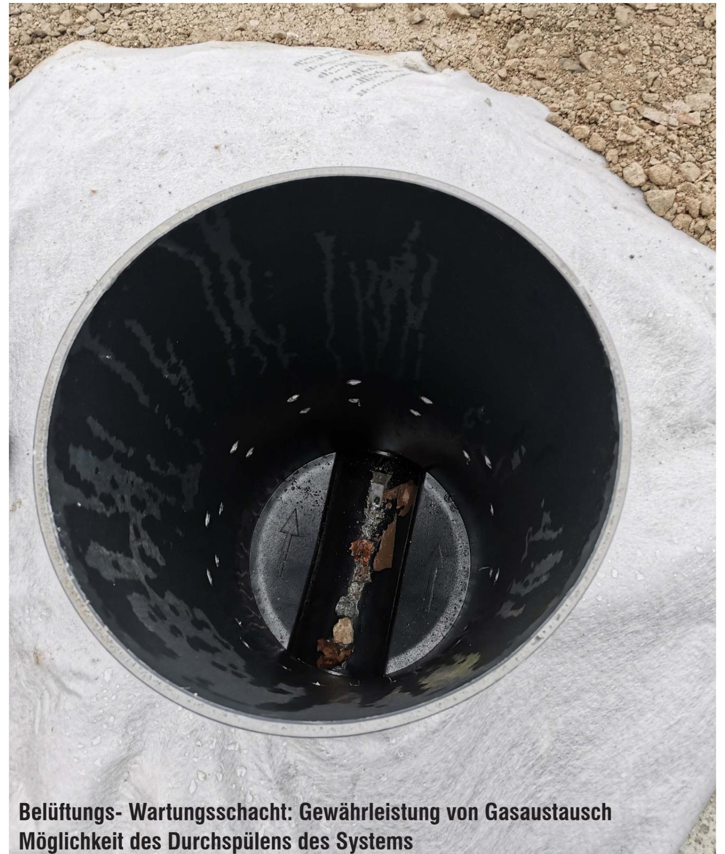
**Belüftungs- Wartungsschacht: Gewährleistung von Gasaustausch
