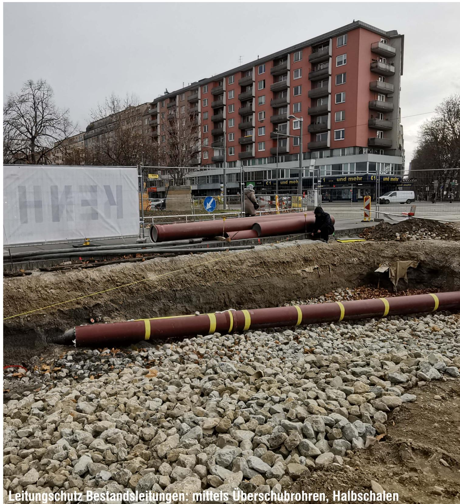
Leitungschutz Bestandsleitungen: mittels Überschubrohren, Halbschalen
