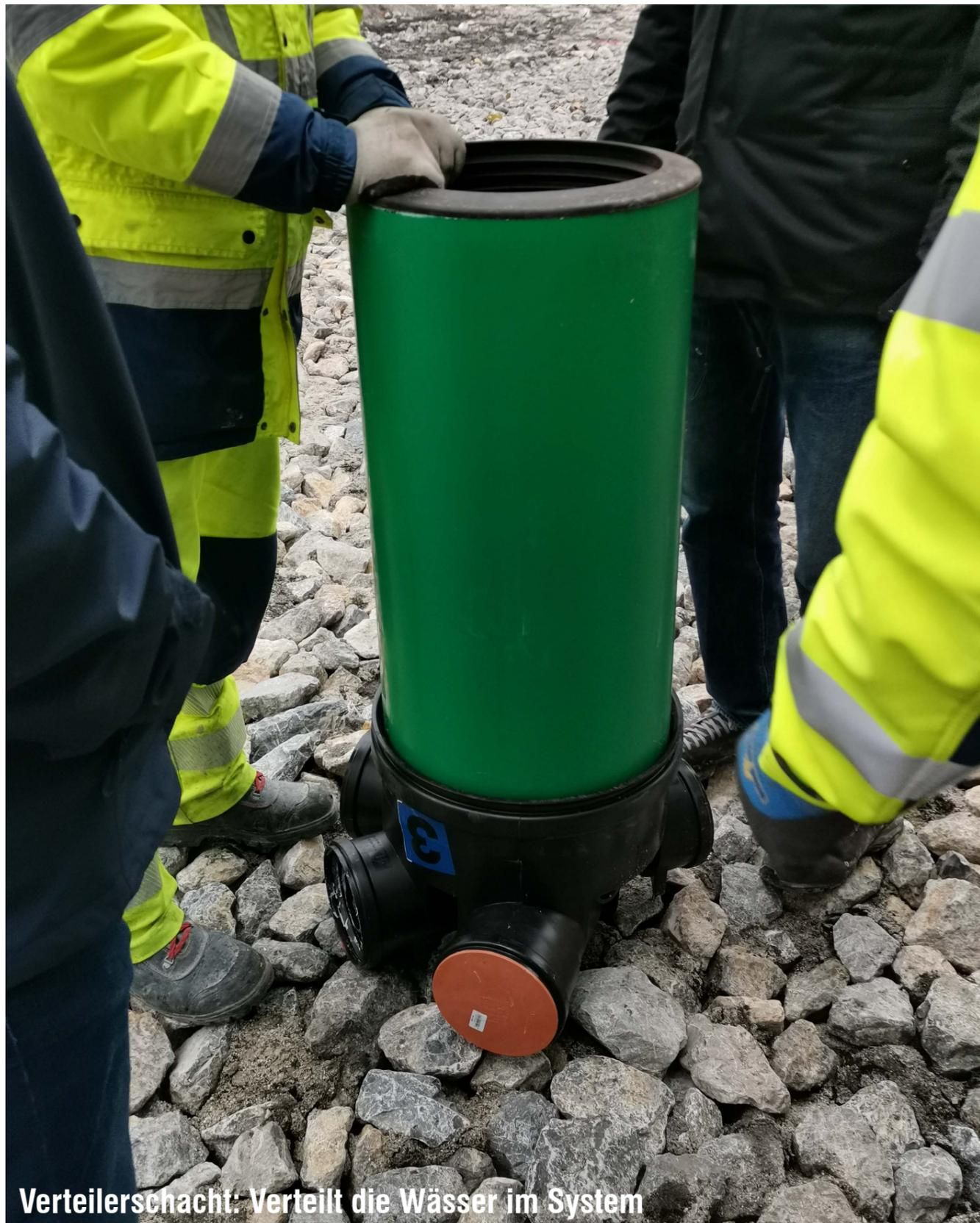
**Verteilerschacht: Verteilt die Wasser im System**
