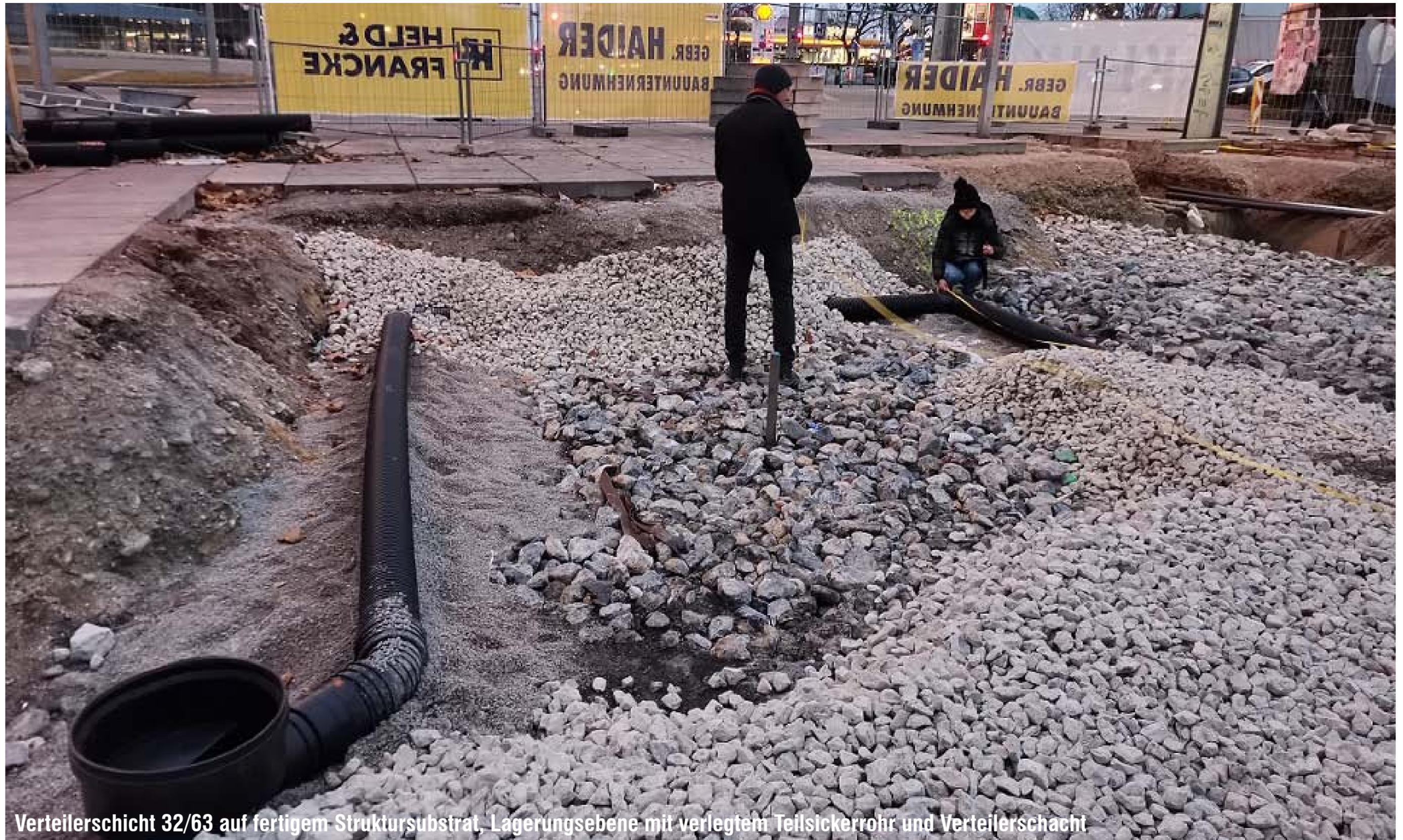
Verteilerschicht 32/63 auf fertigem Struktursubstrat, Lagerungsebene mit verlegtem Teilsickerrohr und Verteilerschacht
