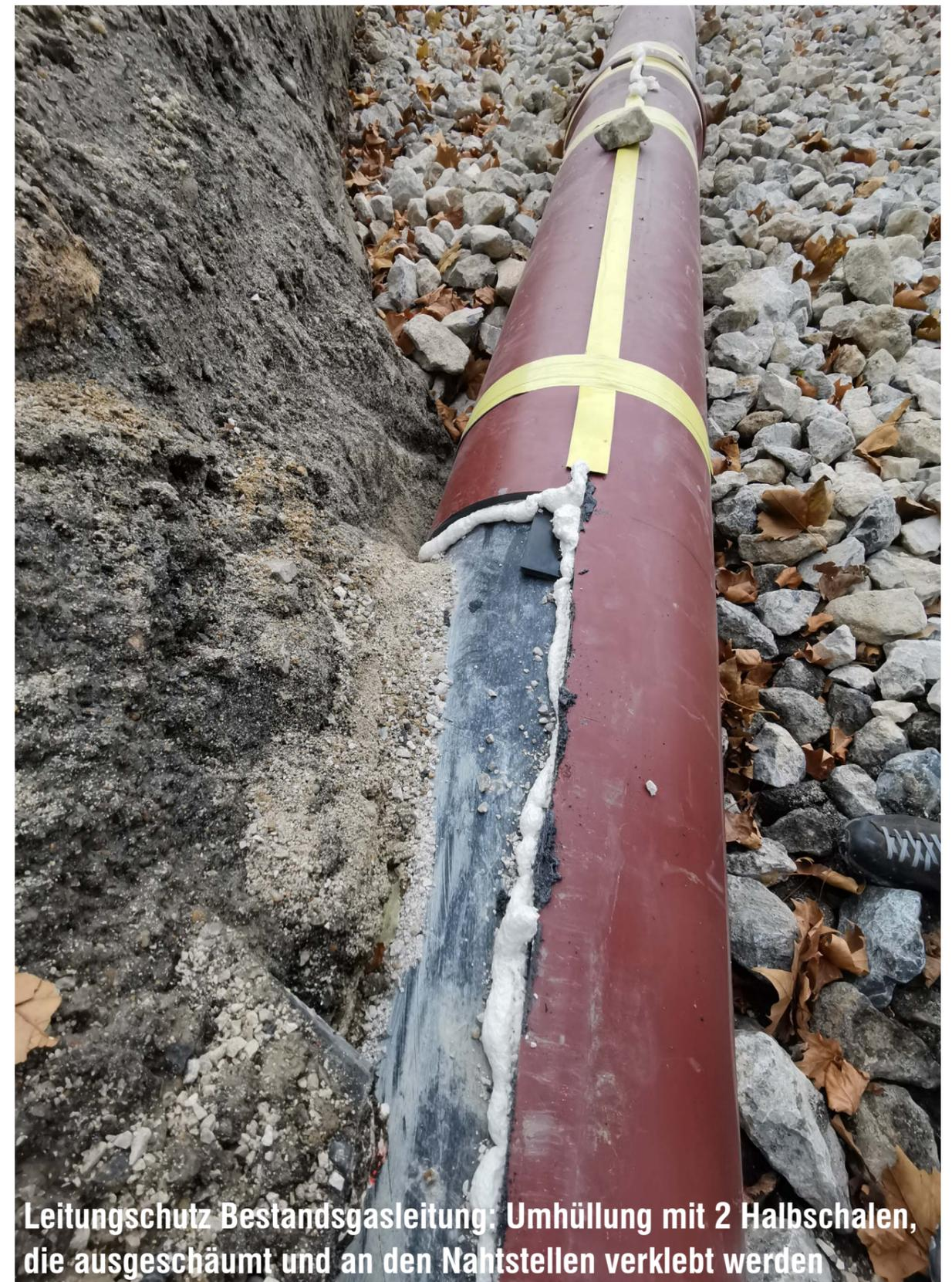
Leitungschutz Bestandsgasleitung: Umhüllung mit 2 Halbschalen, die ausgeschäumt und an den Nahtstellen verklebt werden
