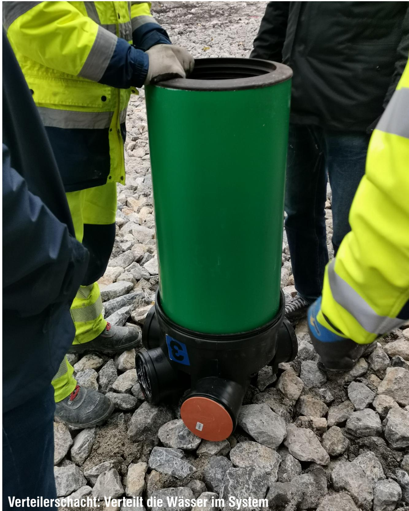
**Verteilerschacht: Verteilt die Wasser im System**
