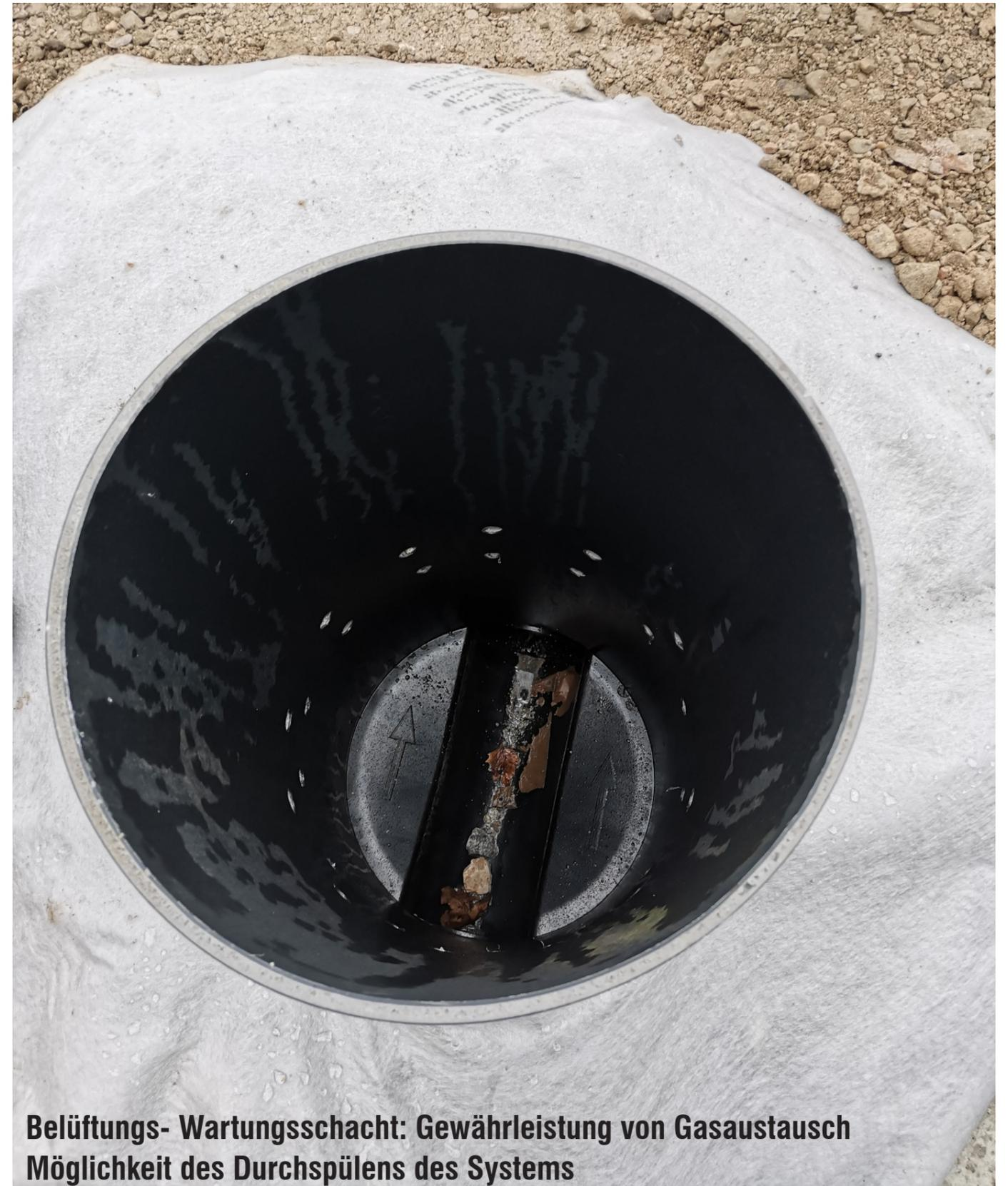
**Belüftungs- Wartungsschacht: Gewährleistung von Gasaustausch
