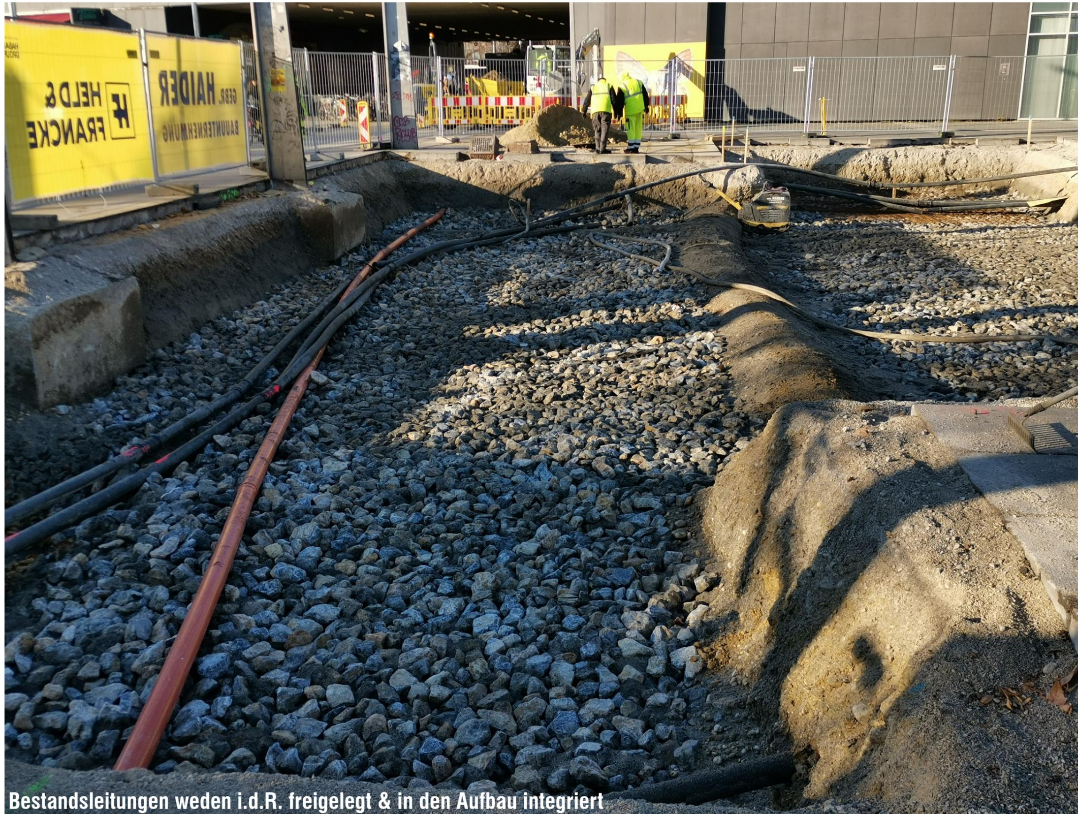
Bestandsleitungen werden i.d.R. freigelegt & in den Aufbau integriert
