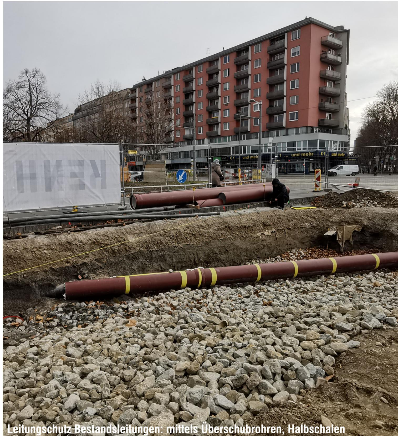
Leitungschutz Bestandsleitungen: mittels Überschubrohren, Halbschalen
